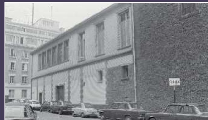
Vue en 1970 de la construction des années 1950 par Oudin et Dresse, avenue Jean Aicard (Casier archéologique).
