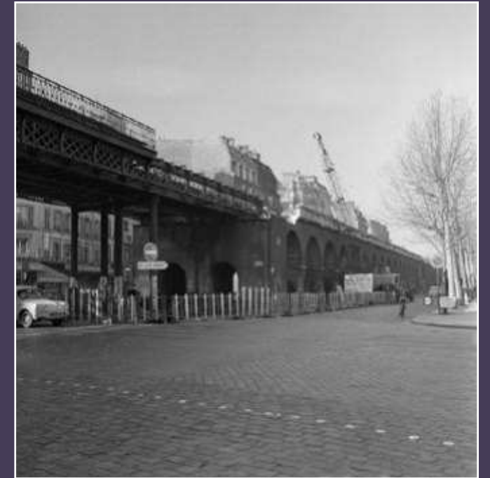
Vue de la démolition de la Petite Ceinture, 1959 (Documentation CVP).
