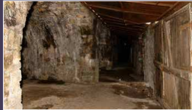
Vue de l'intérieur des voûtes de l'avenue Corentin Cariou.
