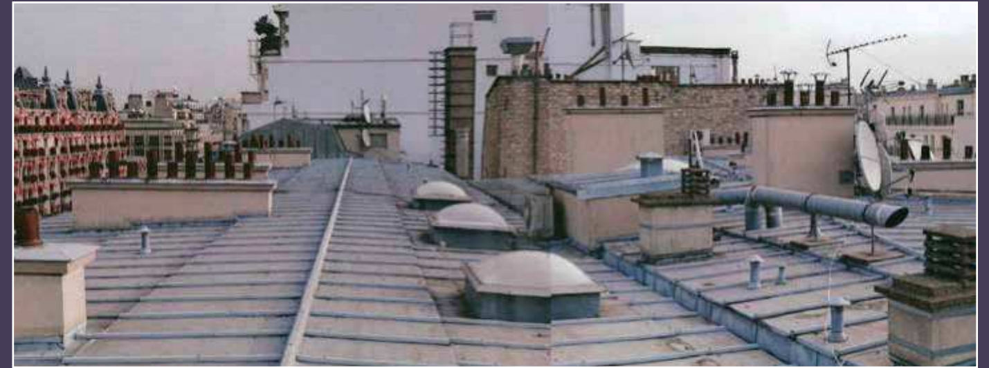
Vue depuis les toits, état existant (© Agence Dary Architectes).
