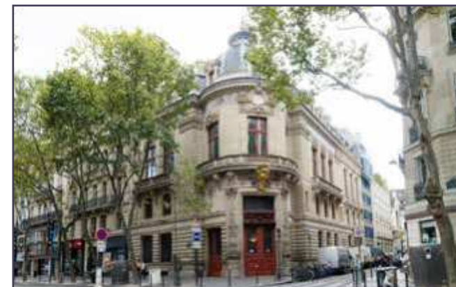
Vue actuelle de l'ancien Cercle de la Librairie de Paris, à l'angle entre le boulevard Saint Germain et la rue Grégoire de Tours.
