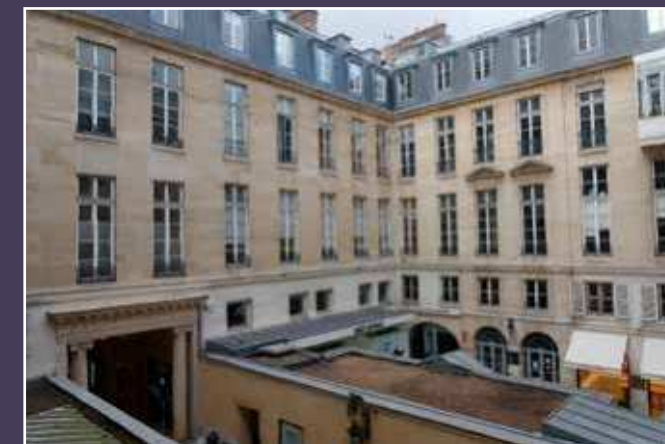
Vue actuelle des façades sur cour.
