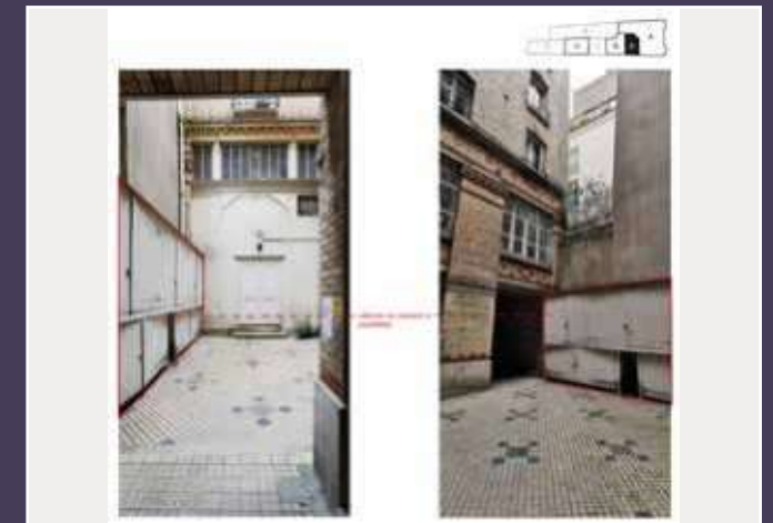
Photographies des éléments dont la démolition ou la dépose est envisagée (© Bona-Lemercier architectes).
