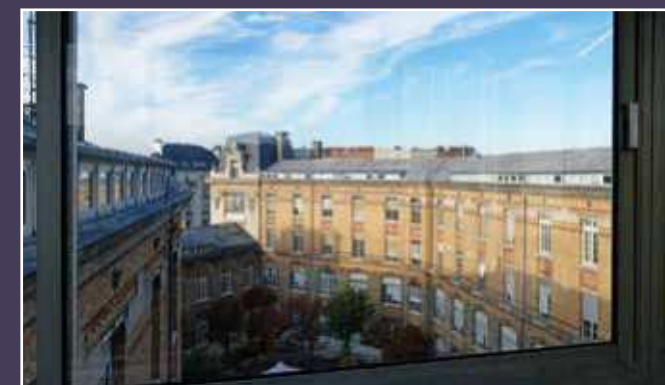
Baies ouvertes en redressement des combles autour de la cour d'honneur.
