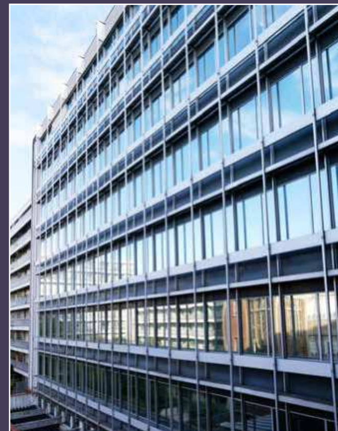
Vue de la façade sur cour du bâtiment élevé par Morandi.
