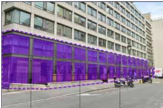
Vue actuelle de la façade, rue Jean Goujon, présentant les démolitions envisagées (© Franklin Azzi Architecte).
