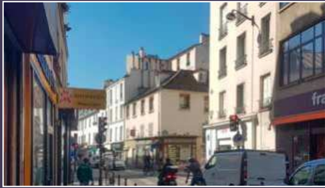
Vue lointaine de la maison, état actuel.
