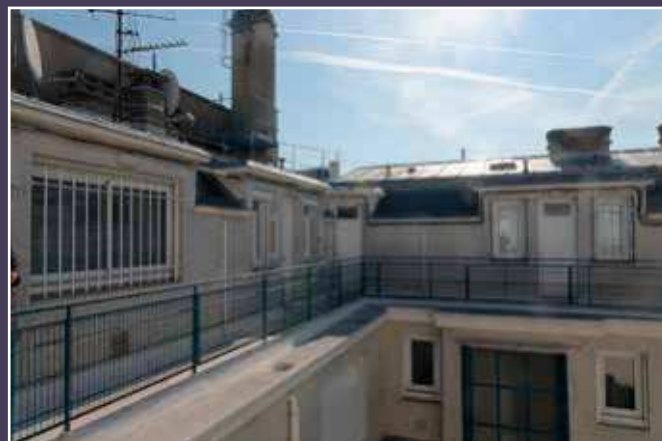
Vue actuelle du dernier étage de l'aile et du corps arrière.
