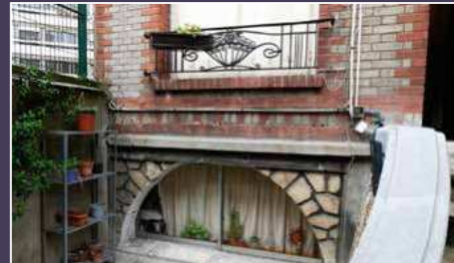
Détail de la façade du bâtiment arrière.
