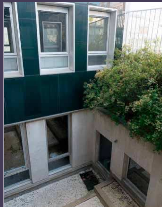
Vue de détail d'un des trois patios.
