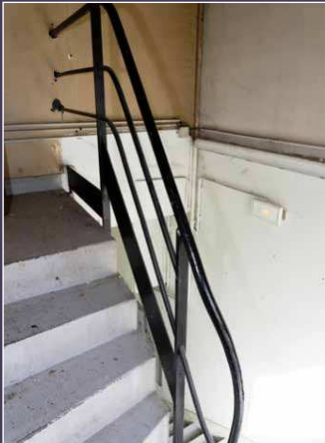
Vue actuelle de l'escalier.
