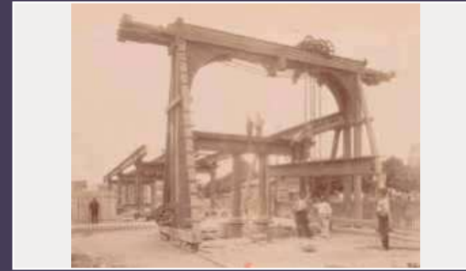
Construction du viaduc du cours de Vincennes, vers 1889 (publié par Albert Broise).
