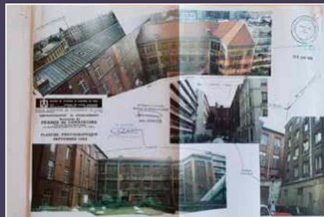
Vues des démolitions demandées en 1993 (Archives de Paris).
