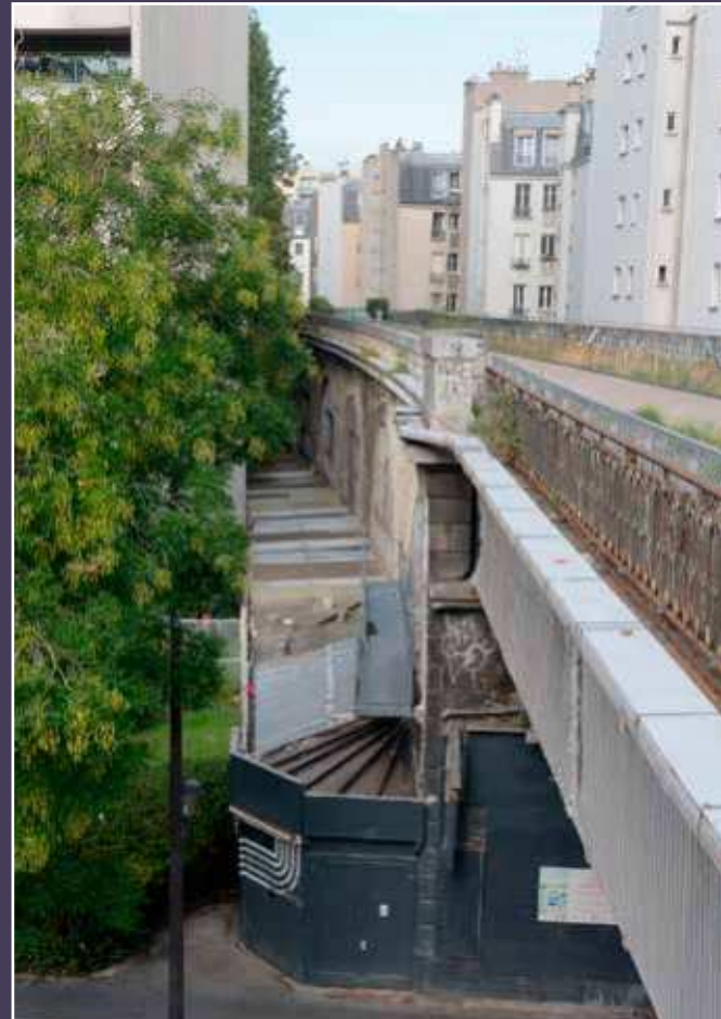
Le site vu depuis la promenade aménagée sur les voies.
