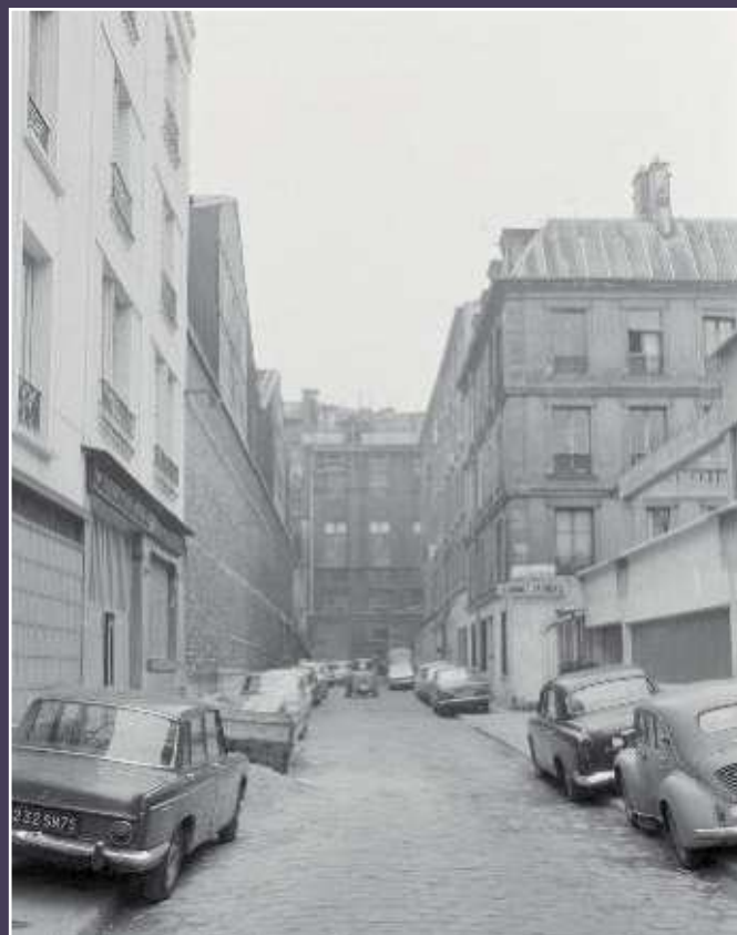
Vue de la Villa Gaudet pendant les travaux de 1970 (Casier archéologique).
