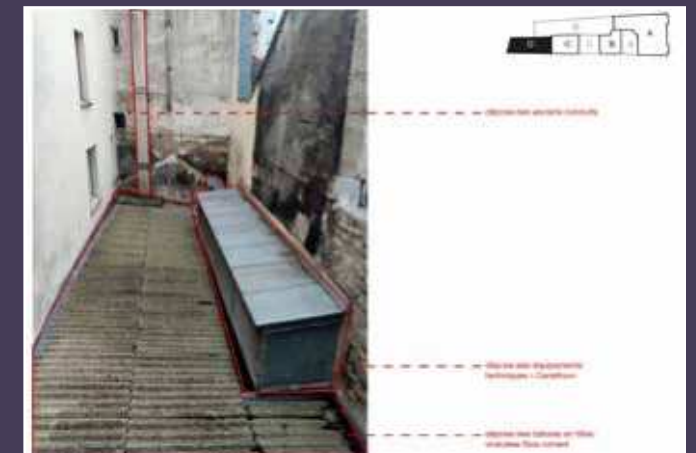
Photographie des éléments dont la démolition ou la dépose est envisagée (© Bona-Lemercier architectes).
