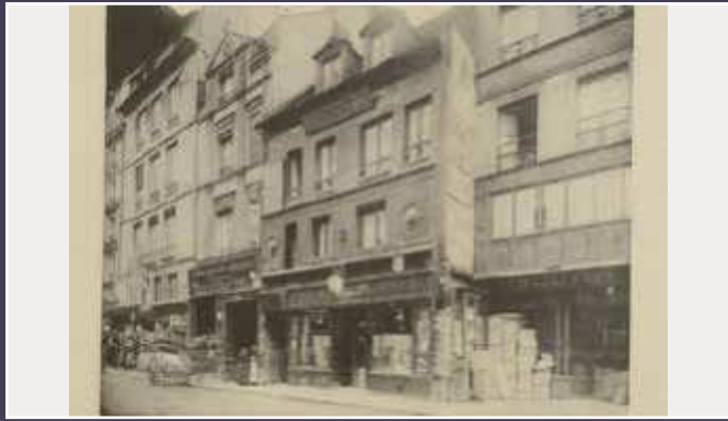
Vue de la rue de Buci, n° 13 à 17, s.d. (BHVP).
