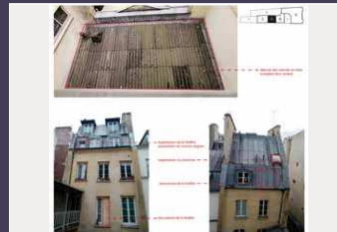
Photographies des éléments dont la démolition ou la dépose est envisagée (© Bona-Lemercier architectes).
