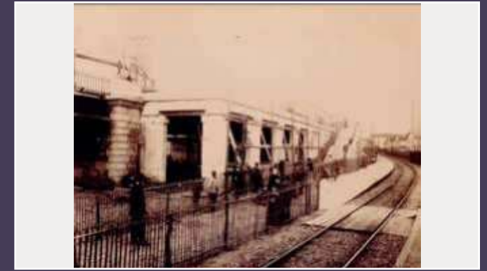
Vue de la seconde gare provisoire de Vincennes en construction, vers 1889 (publié par Albert Broise).
