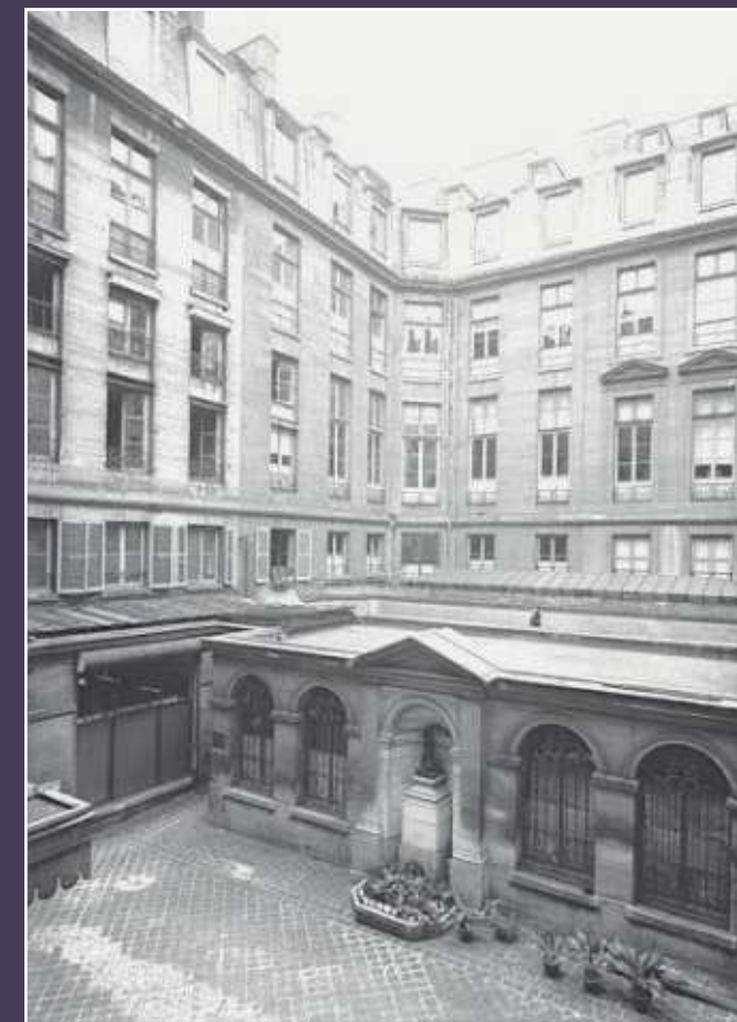
9-11 rue Royale, « Cour commune, architecture ordonnancée », 1953 (Médiathèque du Patrimoine).
