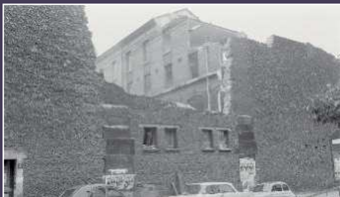
Vue en 1970 de l'avenue Jean Aicard pendant les démolitions (Casier archéologique).
