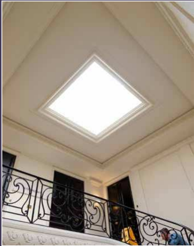
Vue en 2018 du plafond de la cage d'escalier.
