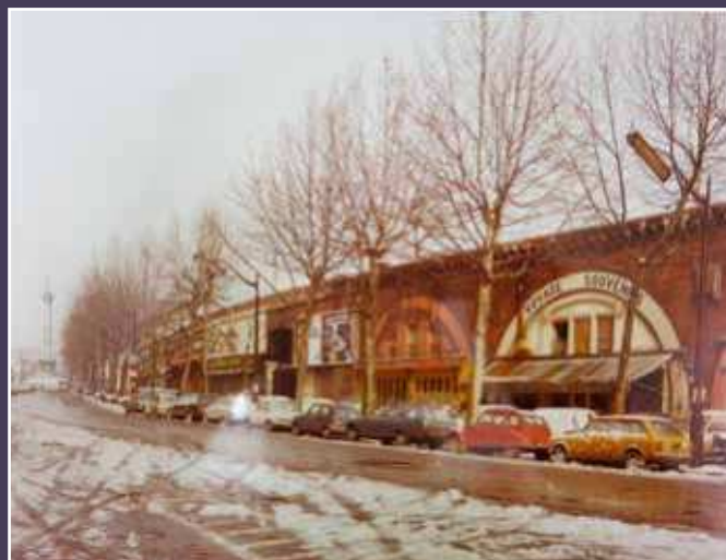
Vue des voûtes du viaduc de l'avenue Daumesnil avant leur réaménagement, vers 1980 (Pavillon de l'Arsenal).
