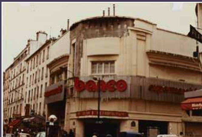
Vue du bâtiment au début des années 1980.
