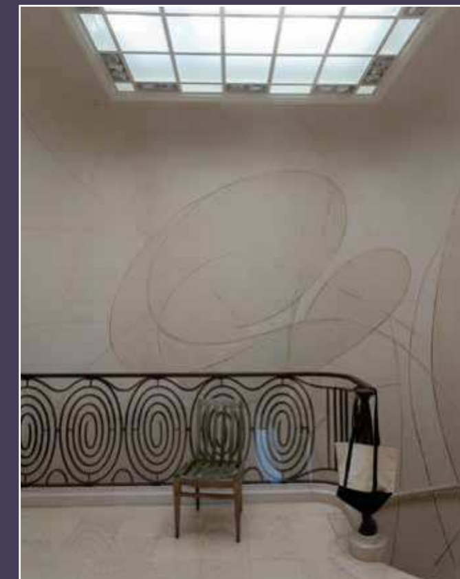
Vue actuelle du palier de l'escalier au dernier étage avec puits de lumière au plafond.
