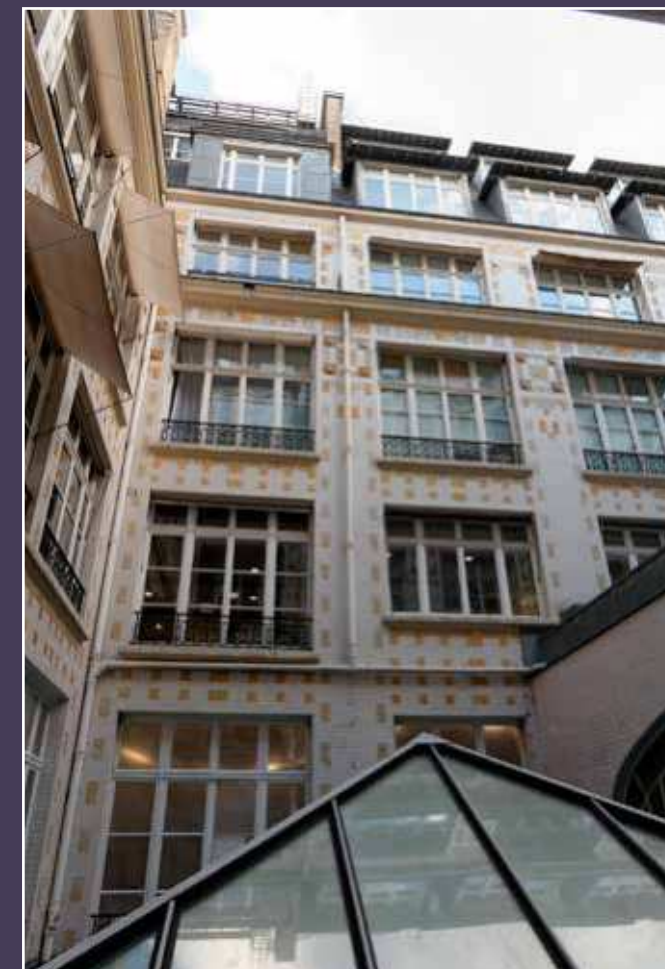
Vue de la cour Boissy, revêtement de céramiques et verrière.
