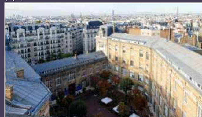
Vue plongeante sur la cour d'honneur et une des deux ailes.
