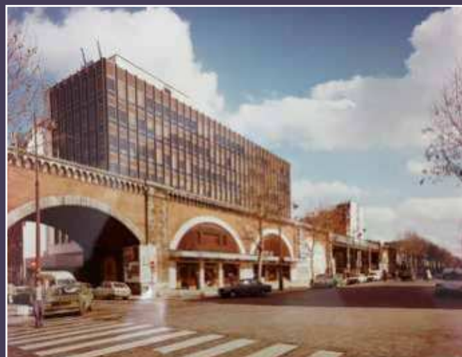
Vue des voûtes du viaduc de l'avenue Daumesnil et un magasin de meuble, vers 1980 (Pavillon de l'Arsenal).
