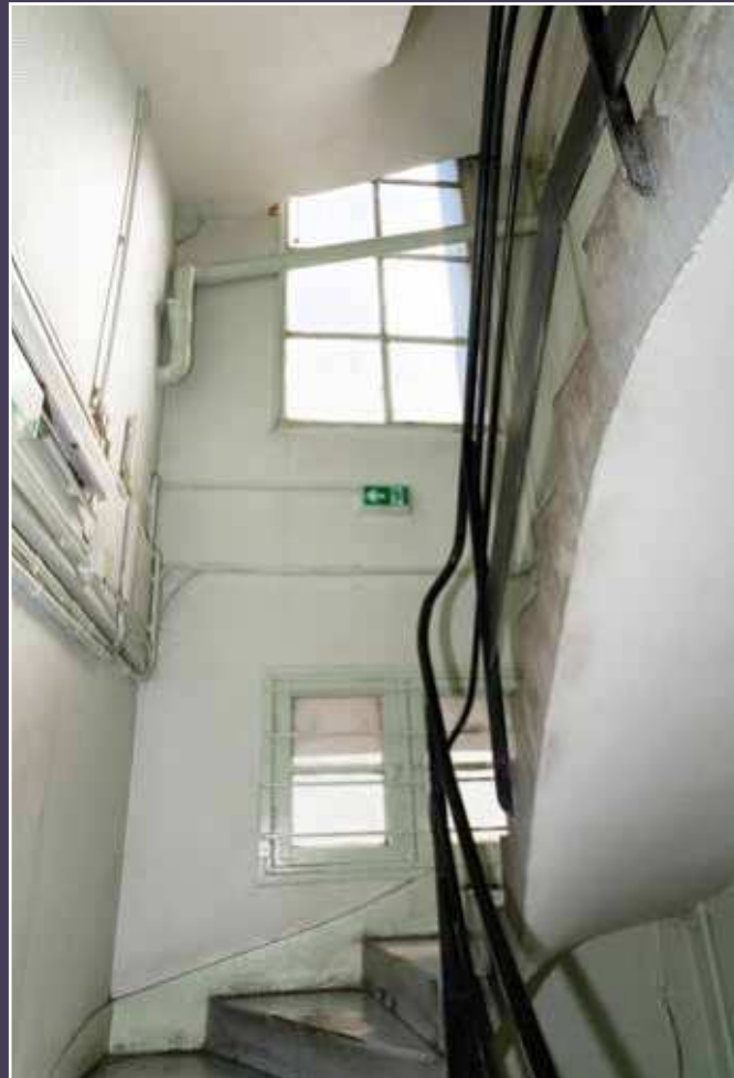
Vue actuelle de l'escalier.
