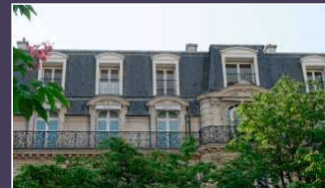
Vue en 2018 de la toiture.
