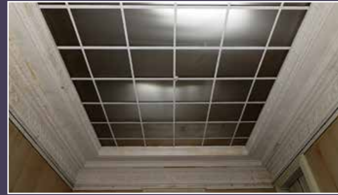
Trianon, vue d'un des faux plafonds.
