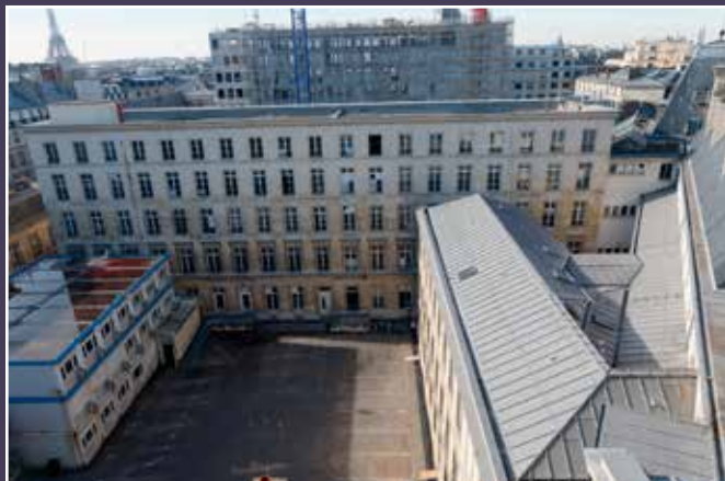
Vue de la cour de la bibliothèque.
