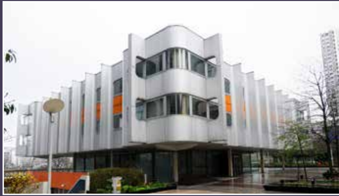
Vue actuelle depuis la dalle.
