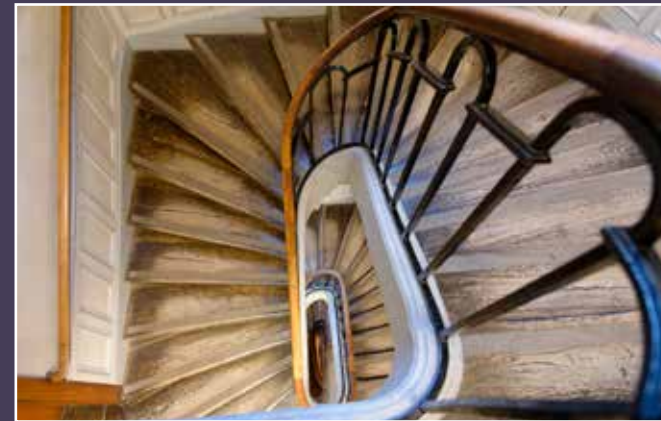
Escalier du bâtiment d'administration.
