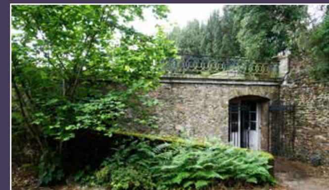
Vue de l'accès à la sous-terrasse ouest.
