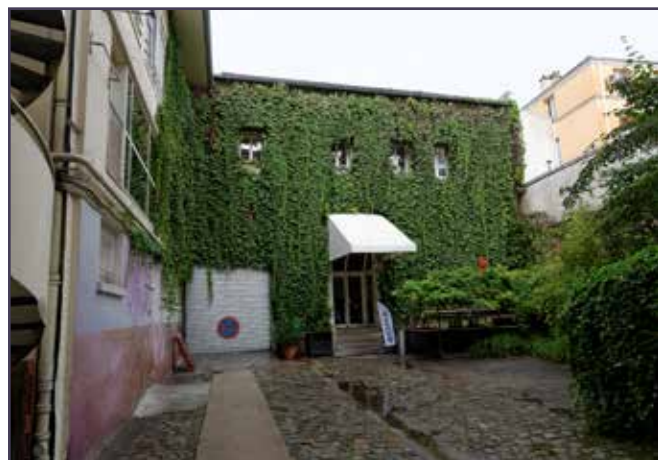
Vue de la façade de l'entrepôt en 2015.
