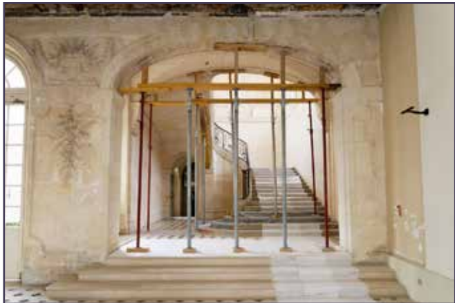
Vue actuelle du vestibule et de la cage de l'escalier d'honneur, avec étaieement.
