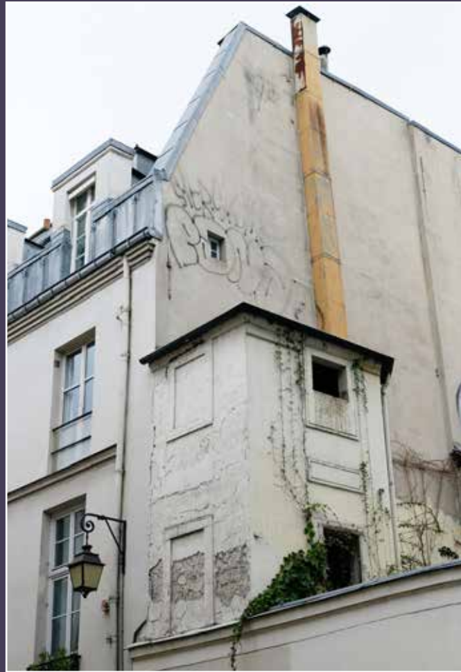
Vue des deux étages du réservoir d'eau.
