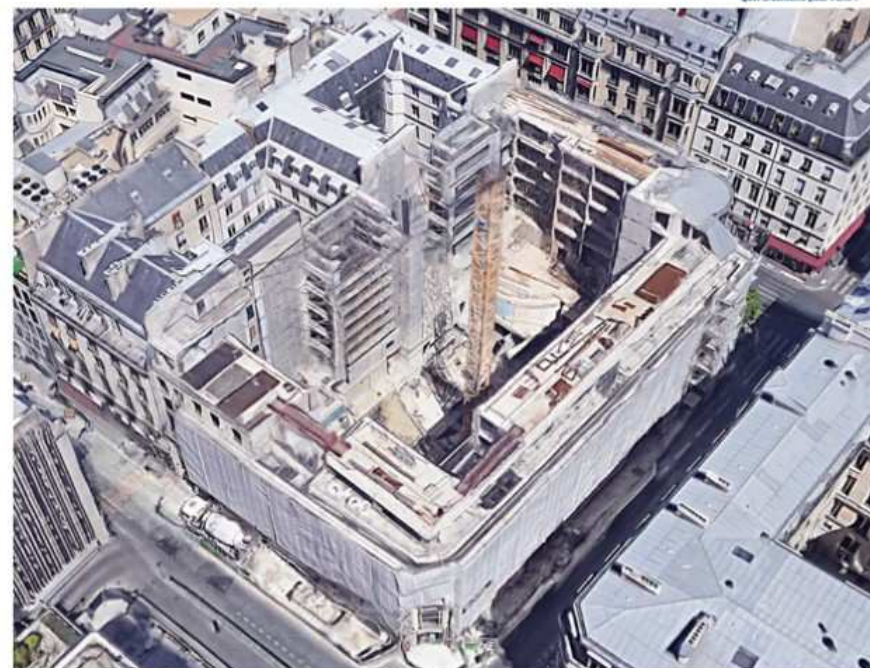
Rénovation lourde, Rue Rossini
