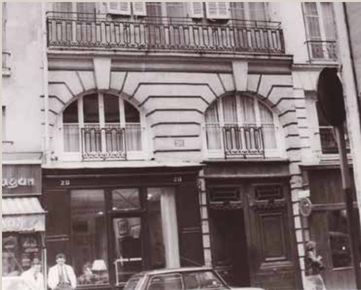
Vue du rez-de-chaussée dans les années 1970.
