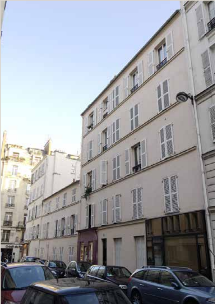
Vue actuelle des façades de la rue Duvivier, vers la rue de Grenelle.
