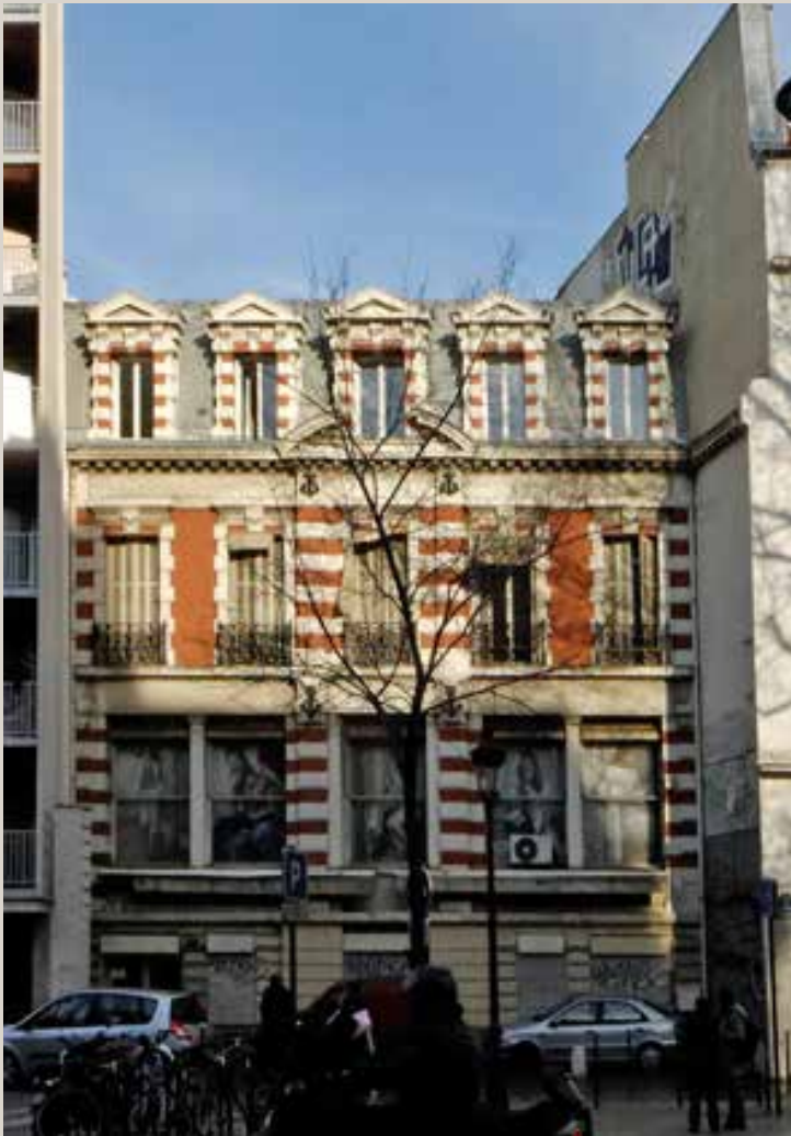
Vue actuelle de la façade dont le rez-de-chaussée et le premier étage ont été remaniés.
