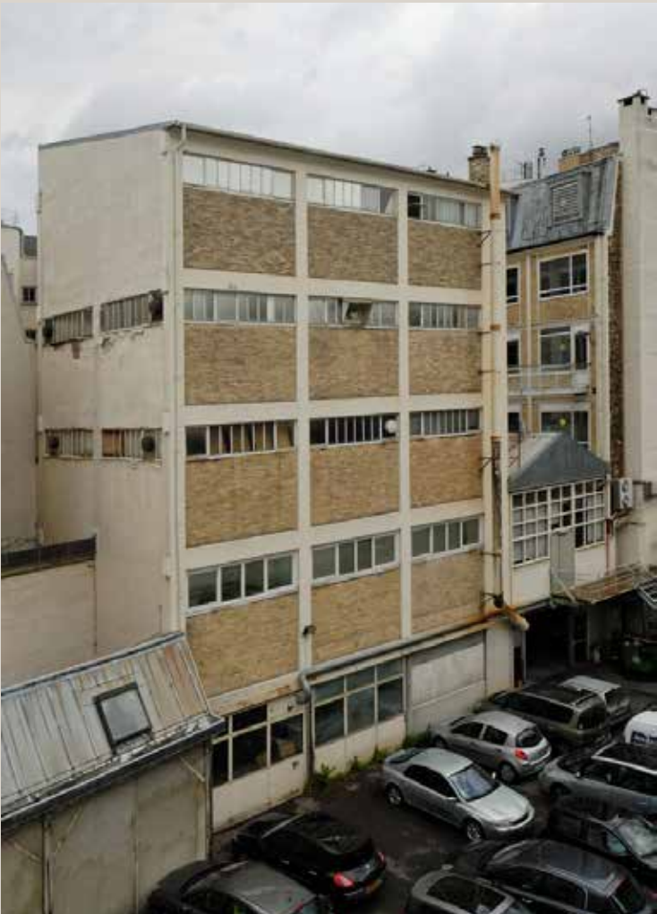
Photo E : vue actuelle de l’extrémité des bâtiments industriels du côté de l’ancien jardin du couvent.
