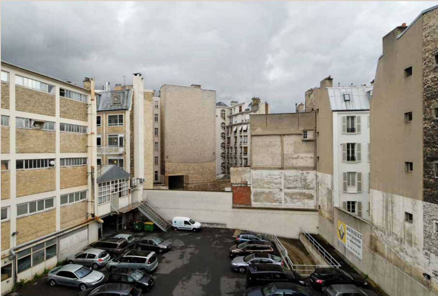
Photo F : vue générale actuelle du cœur de la parcelle, prise depuis l’ancien couvent. À gauche, les bâtiments industriels ; au fond, le patronage accessible par un passage sous le 16, boulevard Raspail. Le mur séparant ces deux parcelles serait démoli pour créer des circulations à l’intérieur de l’îlot.
