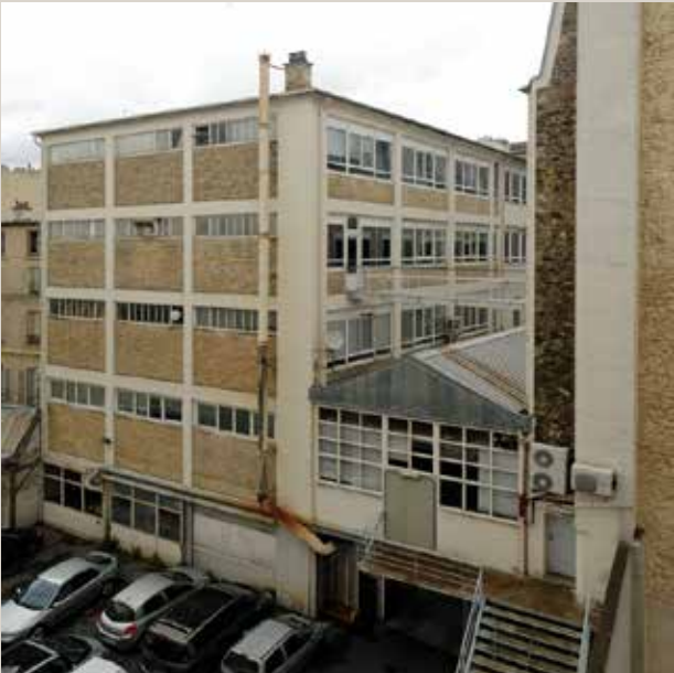
Photo J : vue actuelle des bâtiments industriels.
