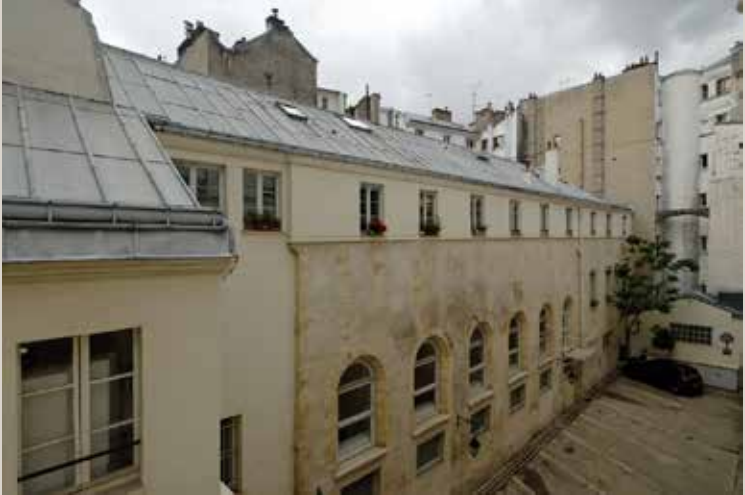
Photo A : vue actuelle de la façade du chœur des religieuses sur la cour.
