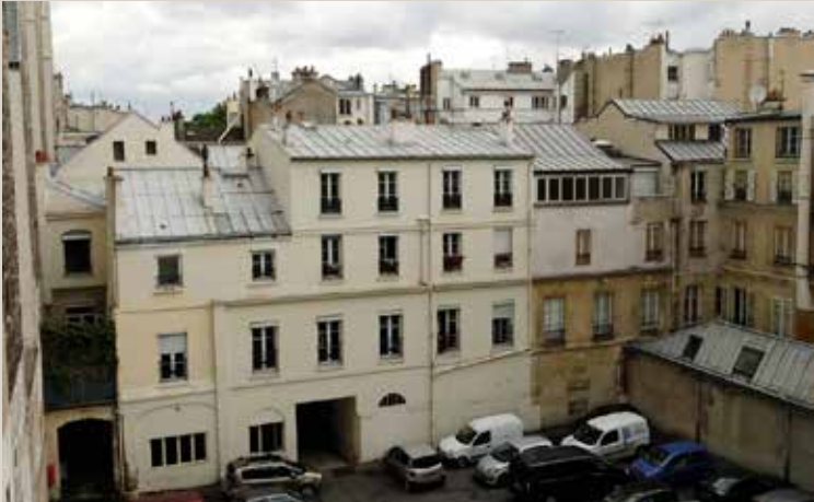
Photo C : vue actuelle du revers du « bâtiment du cloître », donnant initialement sur le jardin du couvent. Depuis, il a été surélevé et les arcades du rez-de-chaussée ont été bouchées.
