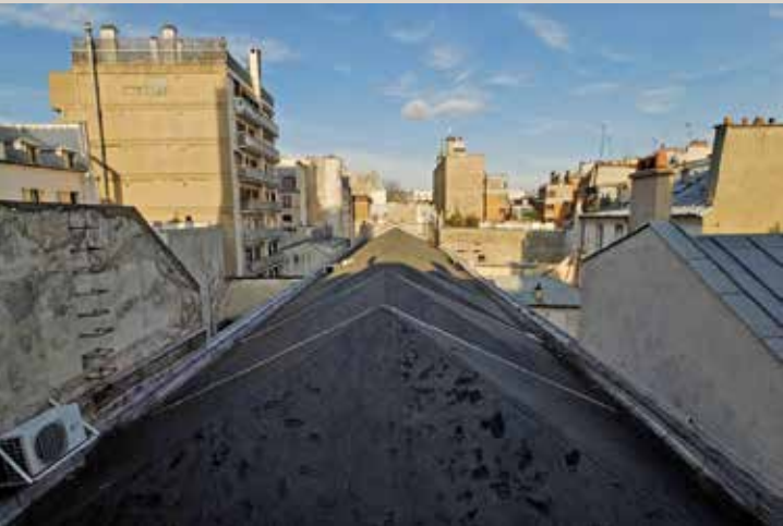
Vue depuis la façade arrière du bâtiment sur rue montrant la couverture en sheds des ateliers qui occupent l'arrière de la parcelle en lanière.
