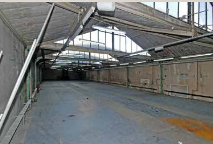
Vue du premier étage des ateliers.
