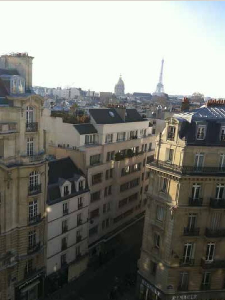
Photo D : vue actuelle de l’immeuble construit par Honegger rue de Grenelle.
