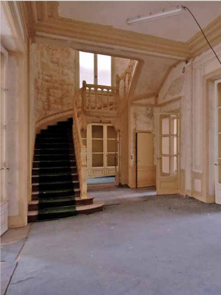
Vue actuelle de l'escalier situé au bout de la galerie du premier étage.
