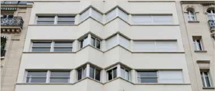
Détail de la façade sur la place après ajout des volets roulants.
