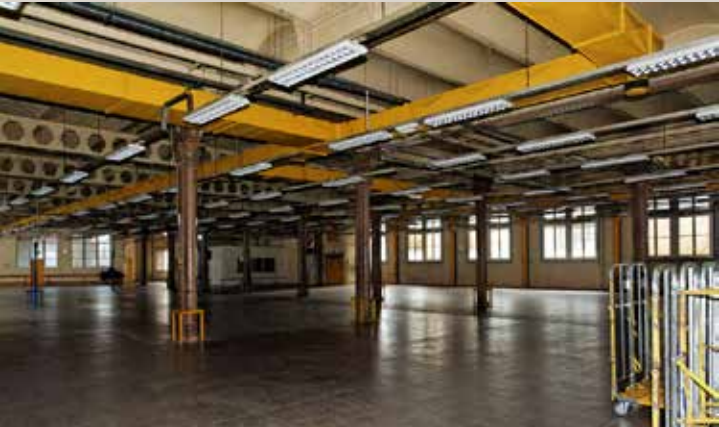
Vue actuelle du plafond du 2 e étage avec la nouvelle charpente.
