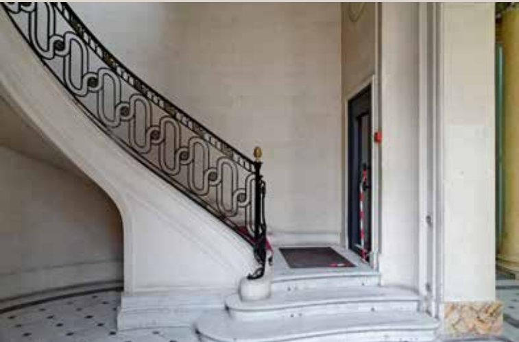
Vue actuelle du départ de l'escalier principal avec à droite la porte de l'ascenseur.
