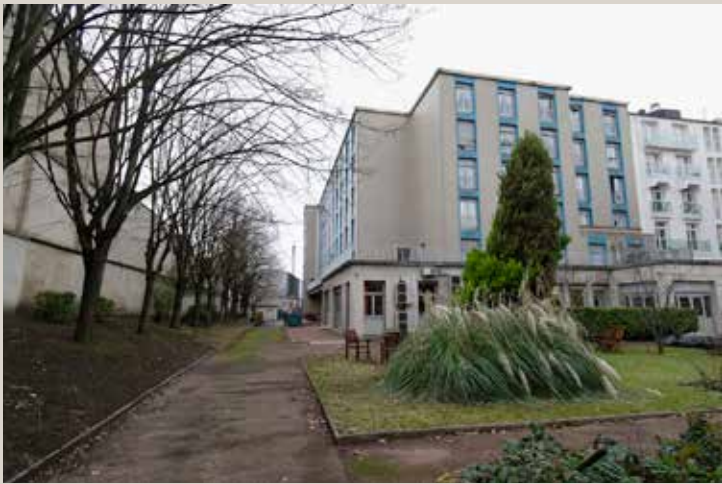
Vue actuelle du bâtiment principal de la maison de retraite depuis le jardin.
