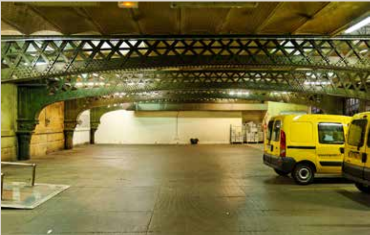
Vue de l'entresol sur rez-de-chaussée (ERDC).
