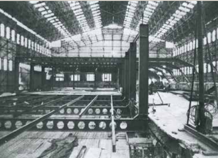
Vue du chantier de reconstruction des toitures vers 1979 suite à l'incendie de 1975 (coll. particulière).
