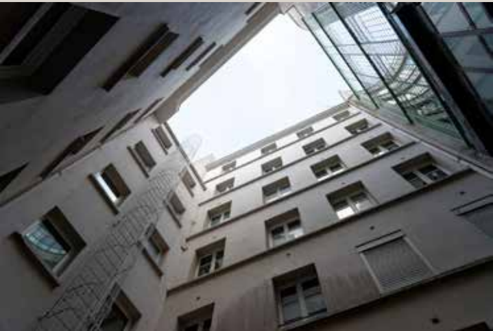
Vue actuelle de la façade sur cour.
