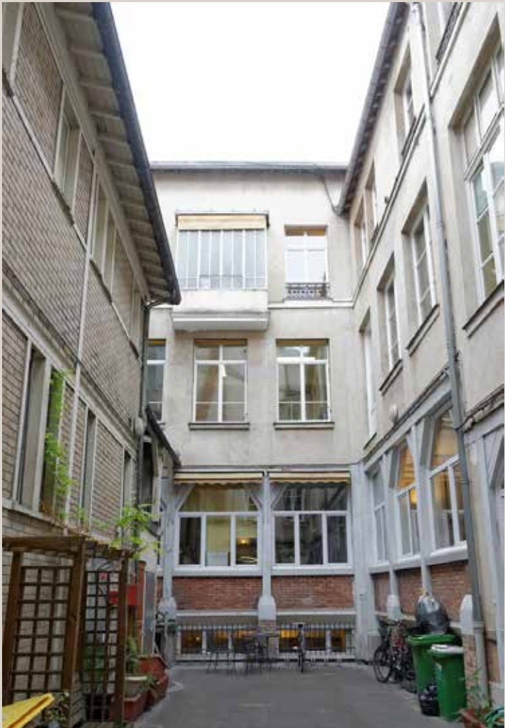
Vue actuelle de la cour intérieure.
