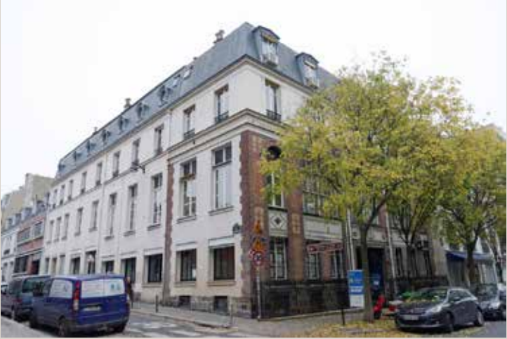
Vue actuelle depuis l'angle des deux voies.
