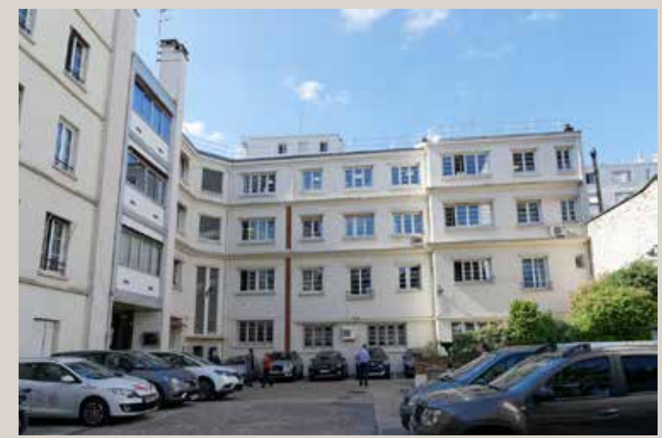
Vue actuelle des façades côté cour.
