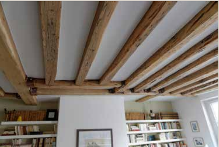
Vue actuelle des éléments de charpente conservés.
