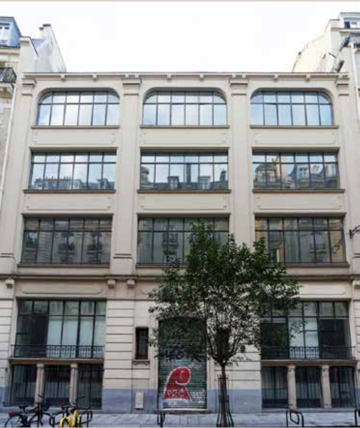
Vue actuelle de la façade sur rue.
