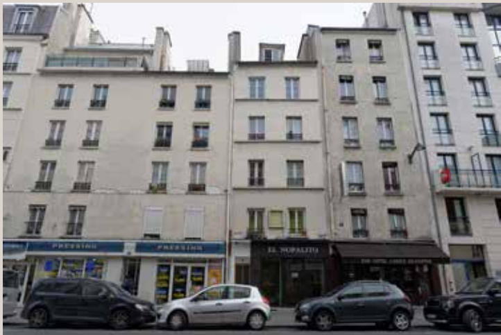
Vue actuelle de la façade sur rue.
