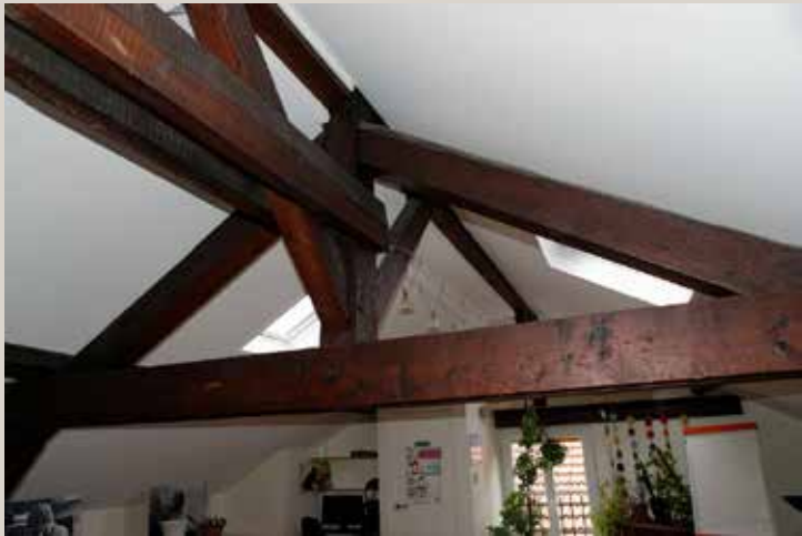
Vue actuelle de la charpente.
