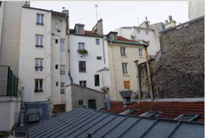
Vue actuelle de la façade sur cour.
