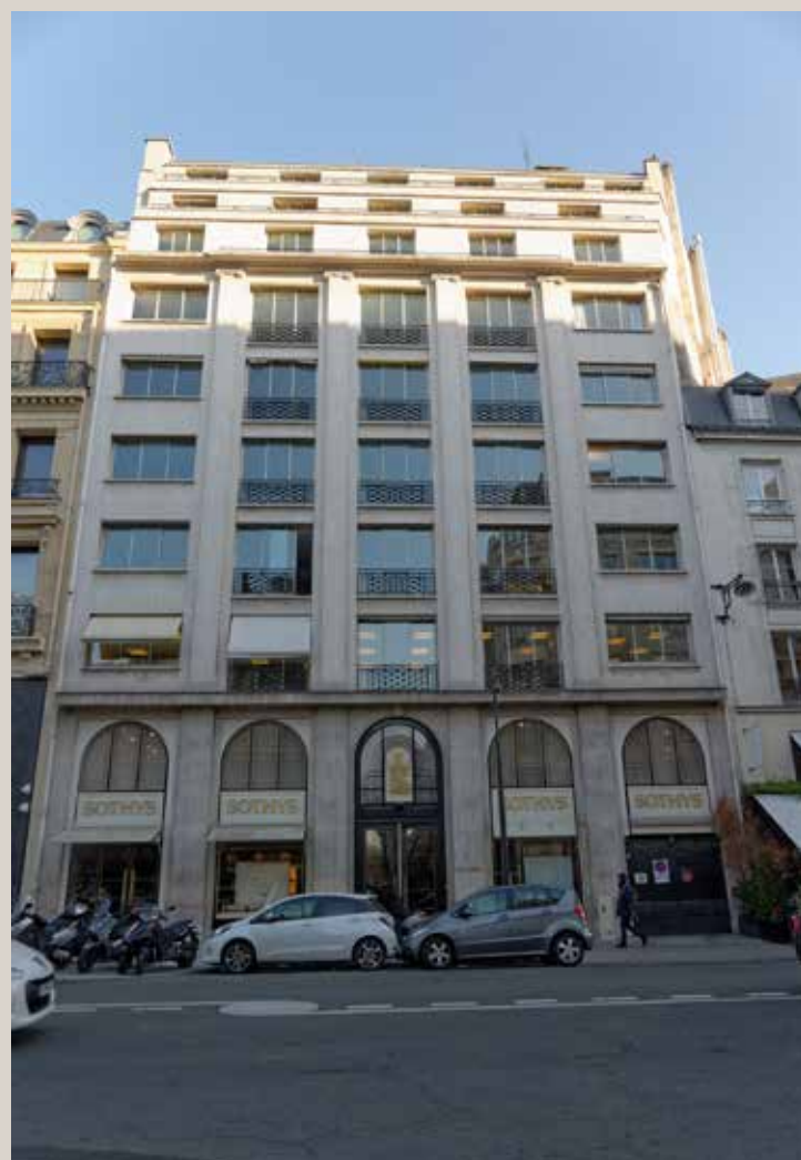
Vue actuelle de la façade sur rue.
