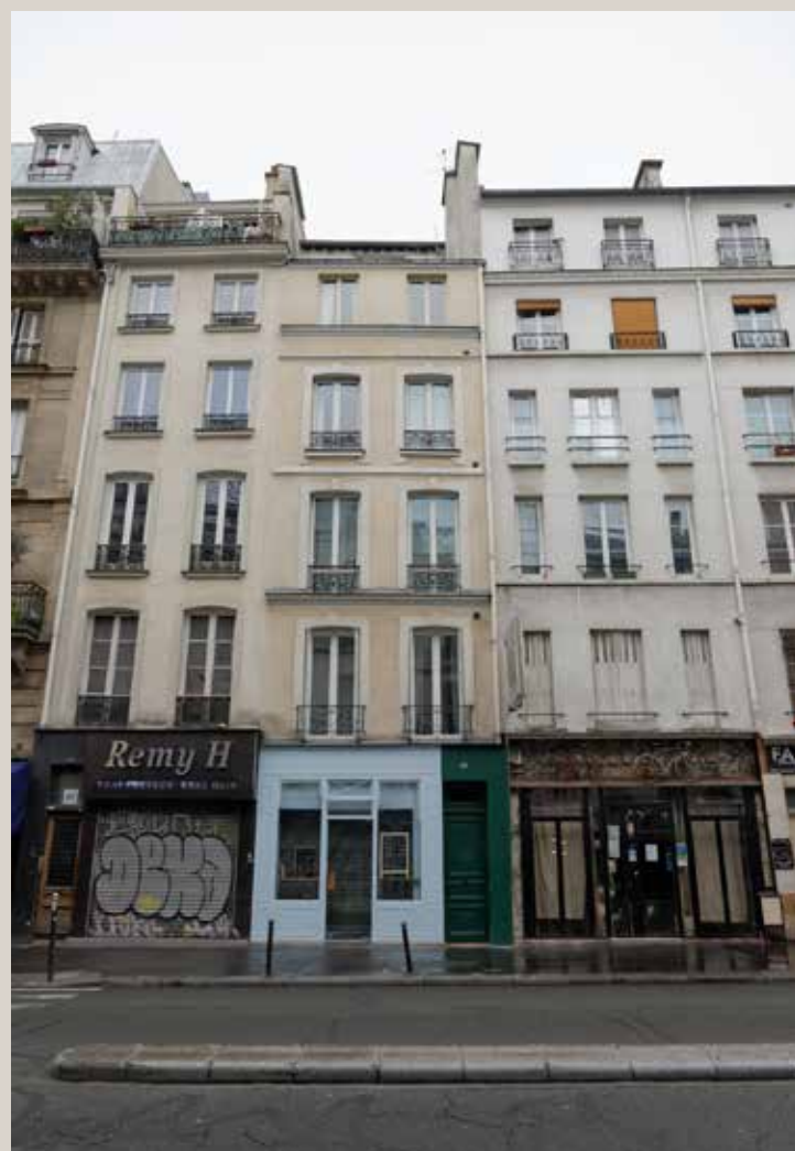
Vue actuelle de la façade sur rue.
