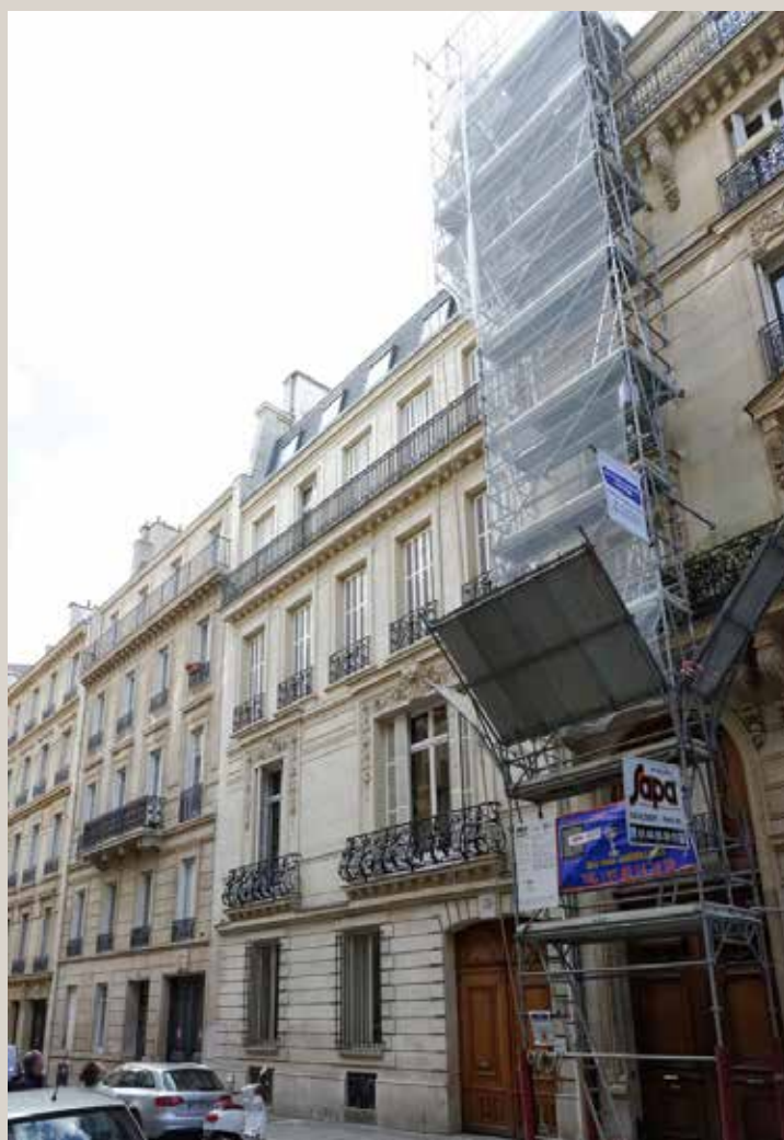
Vue actuelle de la façade sur rue.
