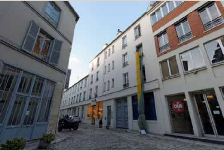
Vue actuelle des façades sur le passage.
