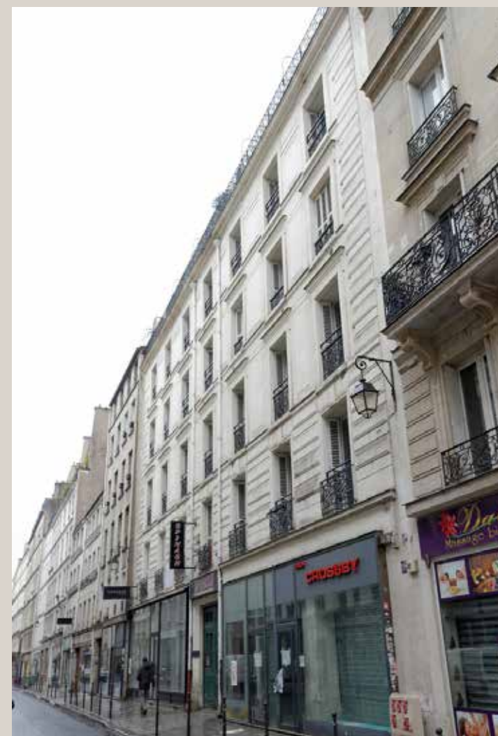
Vue actuelle de la façade sur rue.
