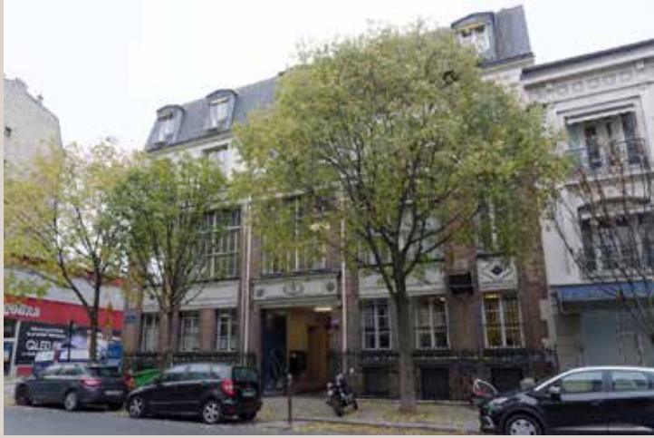
Vue actuelle de la façade sur l'avenue.
