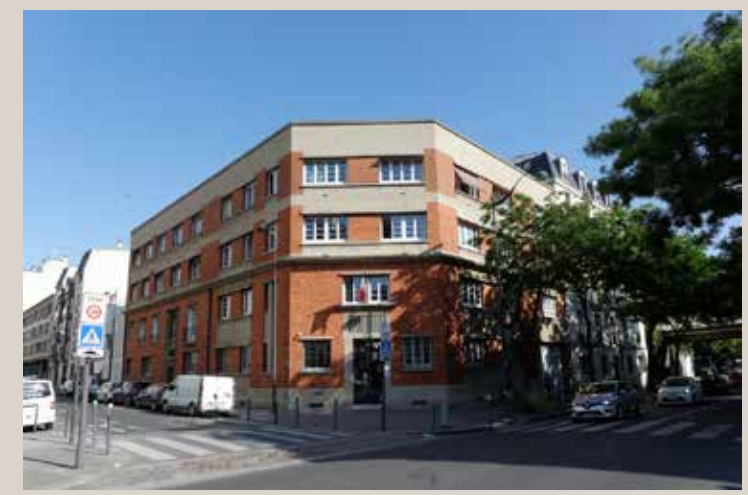
Vue actuelle depuis l'angle des deux voies.
